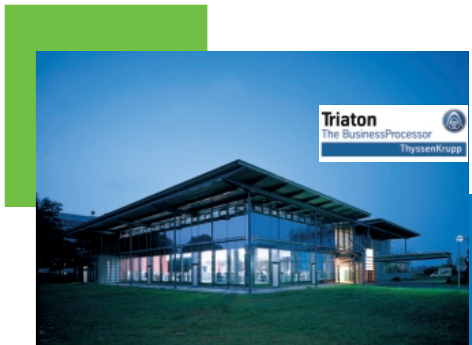
Das Telemanagement-Center der Triaton GmbH in Krefeld.
