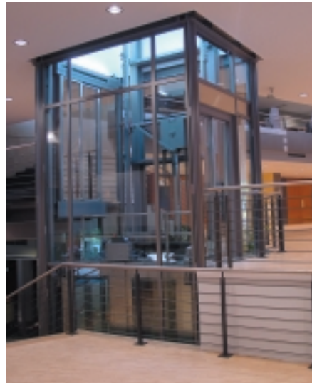
Barrierefreier Zugang zu allen Ebenen der Kongresshalle
