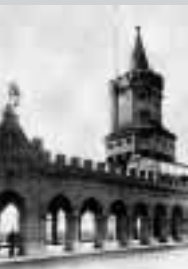
Hochbahn-Viadukt an der Oberbaumbrücke.
