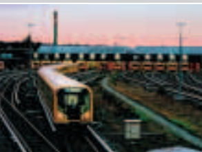
Triebwerkstatt für U-Bahnwagen des Großprofils in Britz.
