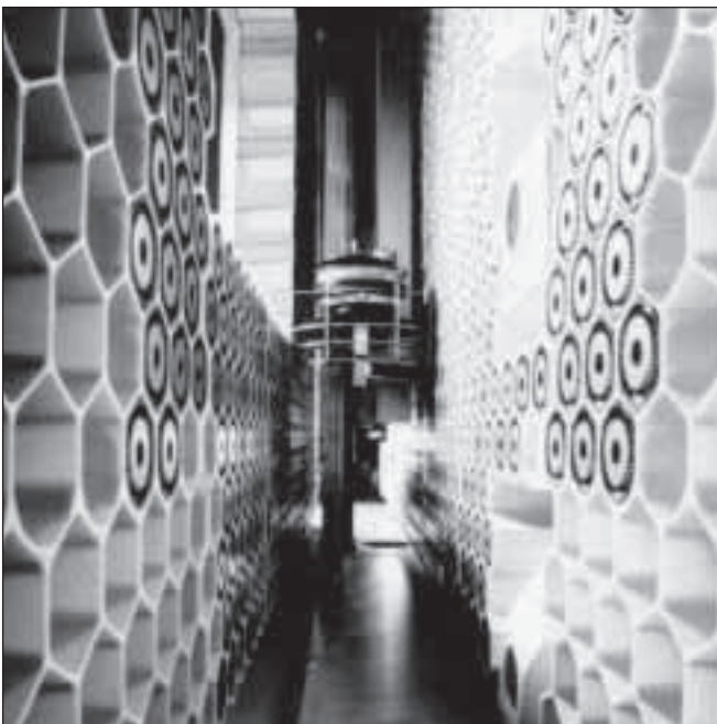
IBM Mass Storage System 3850 mit 'Honeycomb Racks' 1974
