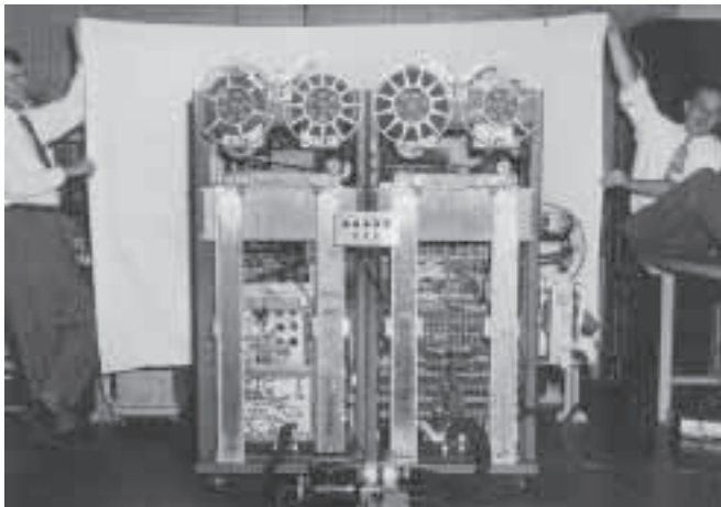
Aufnahme des ersten Prototypen des Magnetbandsystems IBM 726 im Jahr 1951 mit zwei Bandlaufwerken pro Einheit
