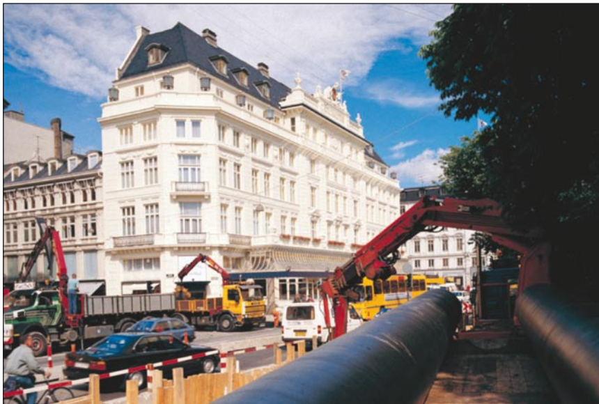
Pipeline von LOGSTOR am Kongens Nytorv in Kopenhagen
